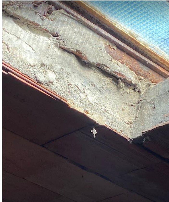
Figura 4: Foto sopralluogo sottostruttura lato interno laterocemento
